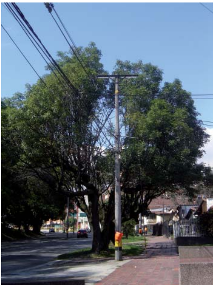
Figura 1. Árboles con necesidad de ser podados por interferencia con sistemas de transmisión y distribución de energía eléctrica.
